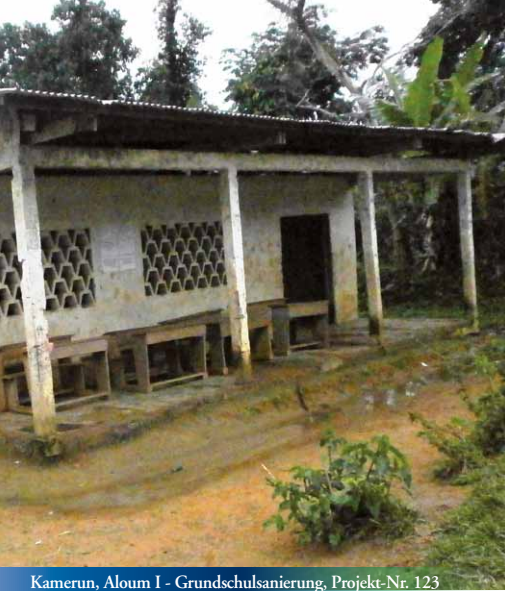
Kamerun, Aloum I - Grundschulsanierung, Projekt-Nr. 123
